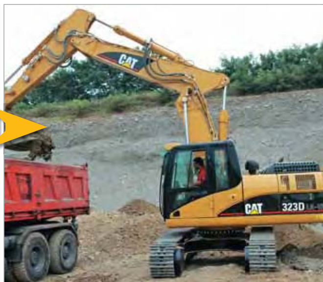
Praca przy budowie autostrady. 2007 r.
