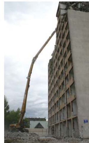
Wyburzany budynek przy ul. Kowalczyka w Warszawie miał 14 kondygnacji i był hotelem pracowniczym. Prace rozbiórkowe zaplanowano na 3 miesiące.
