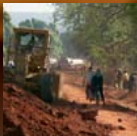
Równiarka samobieżna Cat profiluje drogę w Czadzie.
